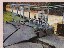
水道の復旧 (被災した浄水場)
