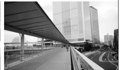
桜木町駅と新市庁舎を結ぶ「さくらみらい橋」
